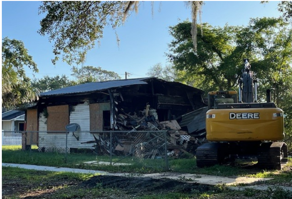
Demolition day – April 17, 2025 (J. West)
