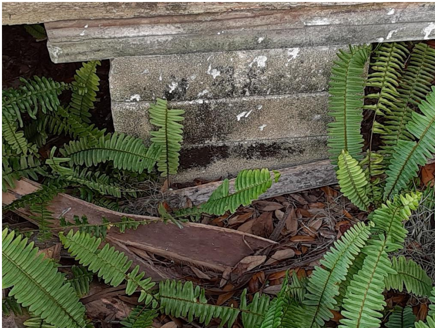
Pier: Concrete block
